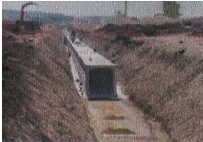
Bild 7: 380-kV-Tunnelanlage in offener Bauweise; Flughafen Madrid
